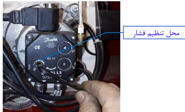
شکل ۱۵) محل تنظیم فشار گازوئیل
